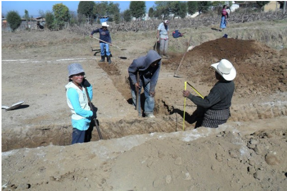
Eltern bei der Mithilfe: Sie heben den Graben für die Fundamente aus und sieben den Bausand in Handarbeit
