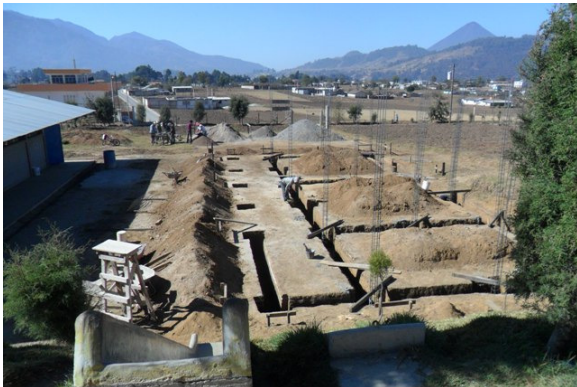
Baufortschritt, Mitte Februar
