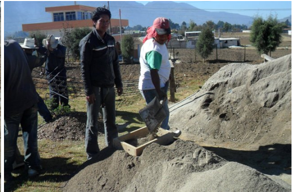
Eltern bei der Mithilfe: Sie heben den Graben für die Fundamente aus und sieben den Bausand in Handarbeit
